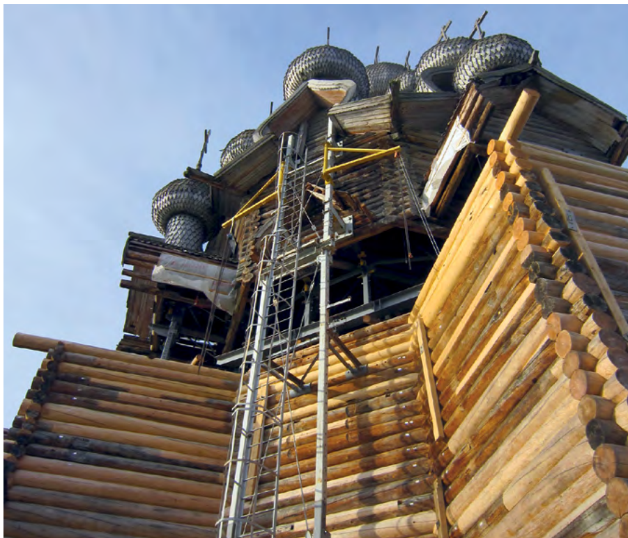
Реставрационные работы в Преображенской церкви в Кижях (Карелия)
